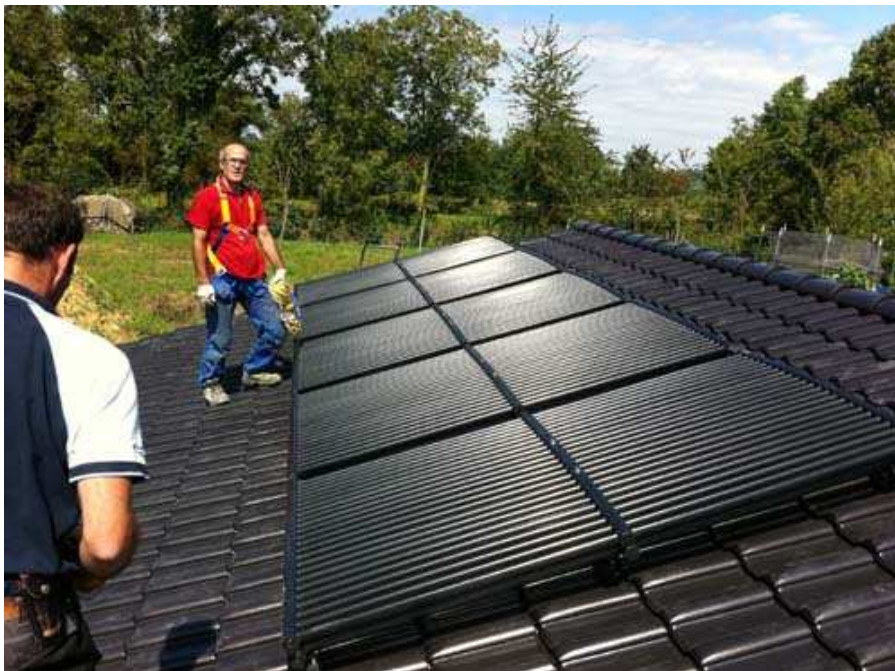
Die Luftabsorber zum Heizen des Gebäudes und zur Regeneration des Eisspeichers wurden montiert.
