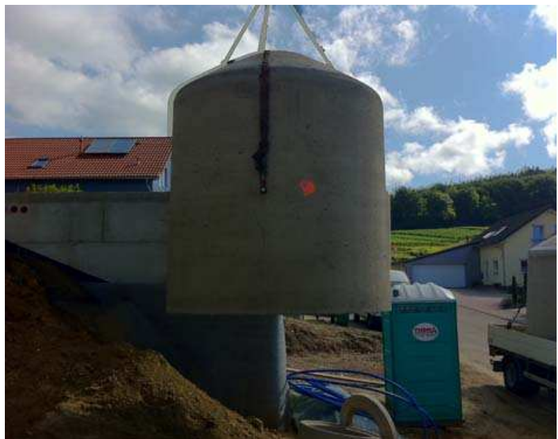
Anlieferung Eisspeicher am 11.07.2011
